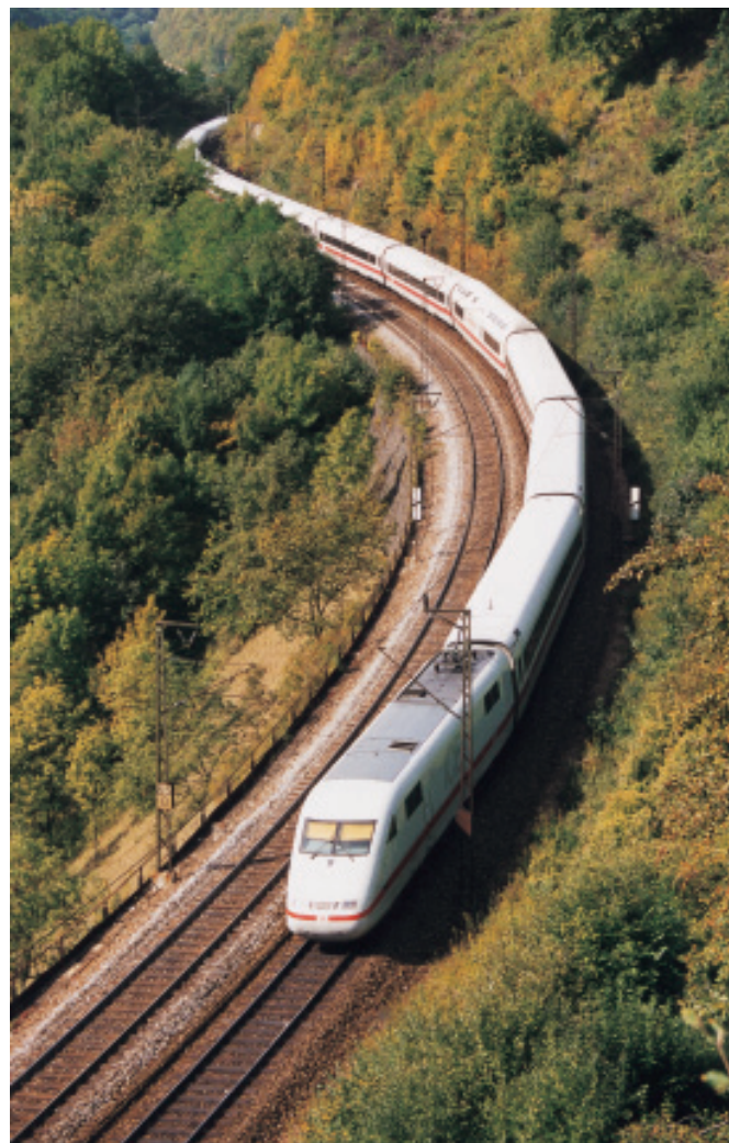
Bild 1: ICE auf der Geislinger Steige. Wegen der Steigung von bis zu 25 Promille und den engen Gleisbögen ist die Geschwindigkeit auf 70 km/h begrenzt.
